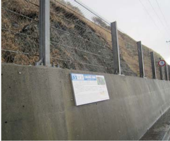
ここが、大昔にぶつかった 2つの陸地の境目です！ 東冬島トンネルを出てすぐ この看板が目印
